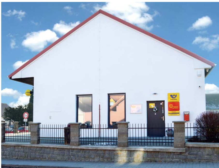
Při rekonstrukci budovy byla odvedena dobrá práce.
